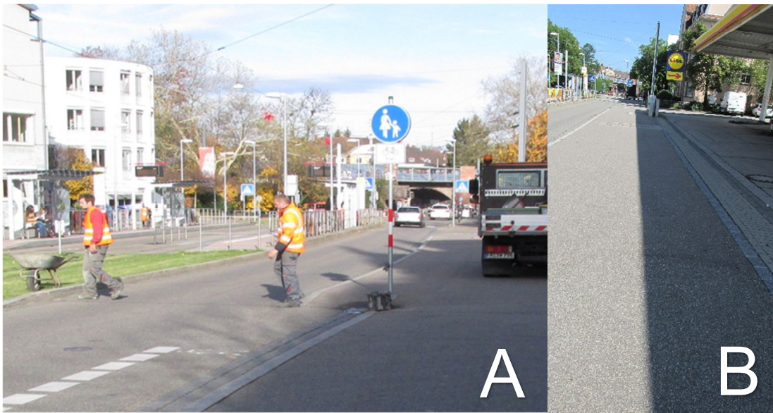
Abbildung 49: Ende des Radfahrstreifens an der Habsburgerstraße, B Gemeinsamer Geh- und Fahrradweg, eigene Aufnahmen
